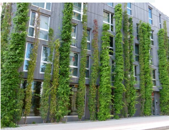
Abbildung 28: Bodengebundene Fassadenbegrünung - Vauban Freiburg, © EGLV, Felizia Kuhlke
