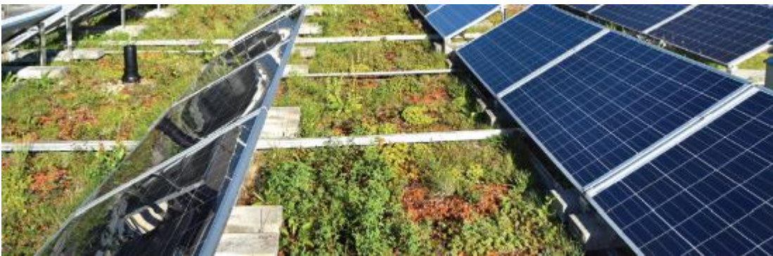
Abbildung 25: Kombination aus Gründach und Photovoltaik – kein Widerspruch, sondern win-win-Situation © Brenneisen, in: Ratgeber Gründach und Photovoltaik 2020, S. 9
