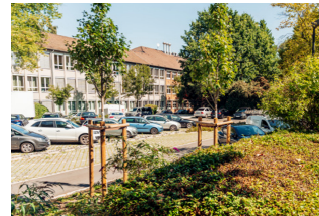
Regenwasser-Speicher: Der Klima.Parkplatz am Sportpark Eickel in Herne ist ein gutes Beispiel für den Umbau von Stadträumen nach dem Prinzip der Schwammstadt.
