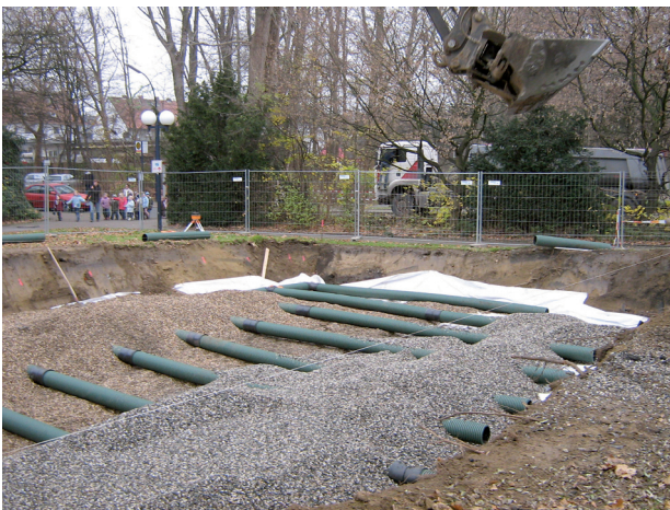
Abb. 5: Holzwickede, Bau der Retentionsmulde
