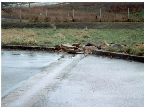
Abb. 2: Fa. Stiebel Eltron, Mulde, Zulauf und Erdwall
