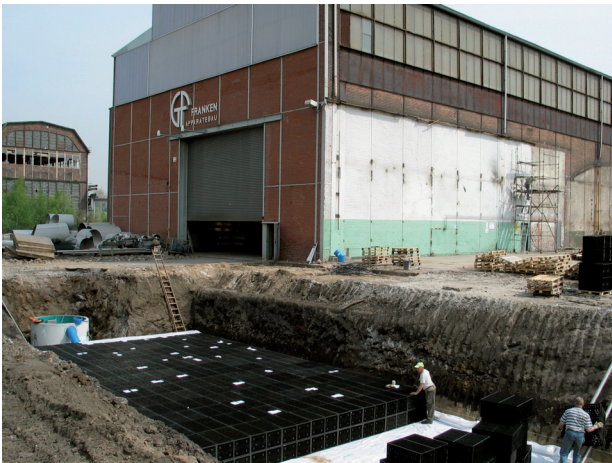
Abb. 3: Fa. Franken, Bau der Rigole
