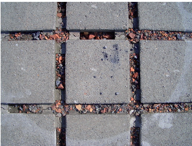
Verschiedene Fugenmaterialien auf den Stellplätzen in Bergkamen
