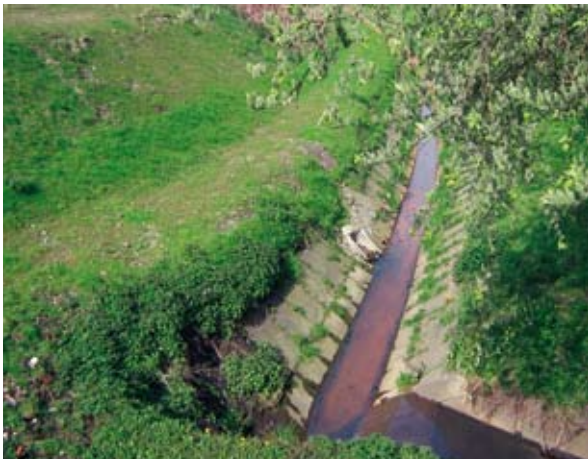
Gewerbepark Schalke: ein unauffälliger Auslass am Ende einer 16,2 ha großen befestigten Fläche (Sellmannsbach vor der ökologischen Verbesserung)
