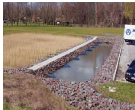
Fa. Dewender: Absetzbecken und Pflanzenklärbeet sorgen für die Reinigung der Niederschlagsabflüsse
