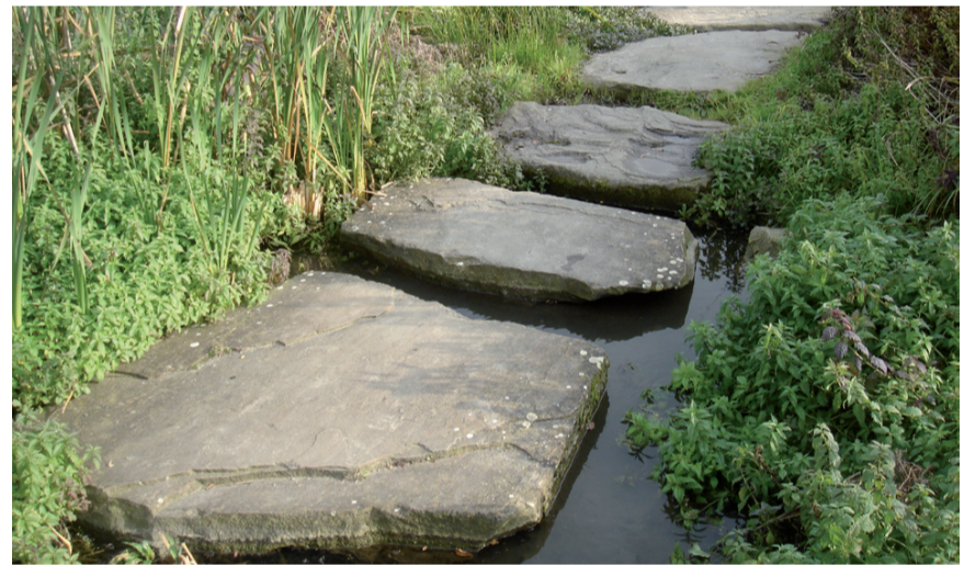
Abb.3: Regenwasserableitung Gewerbepark Erin in Castrop-Rauxel
