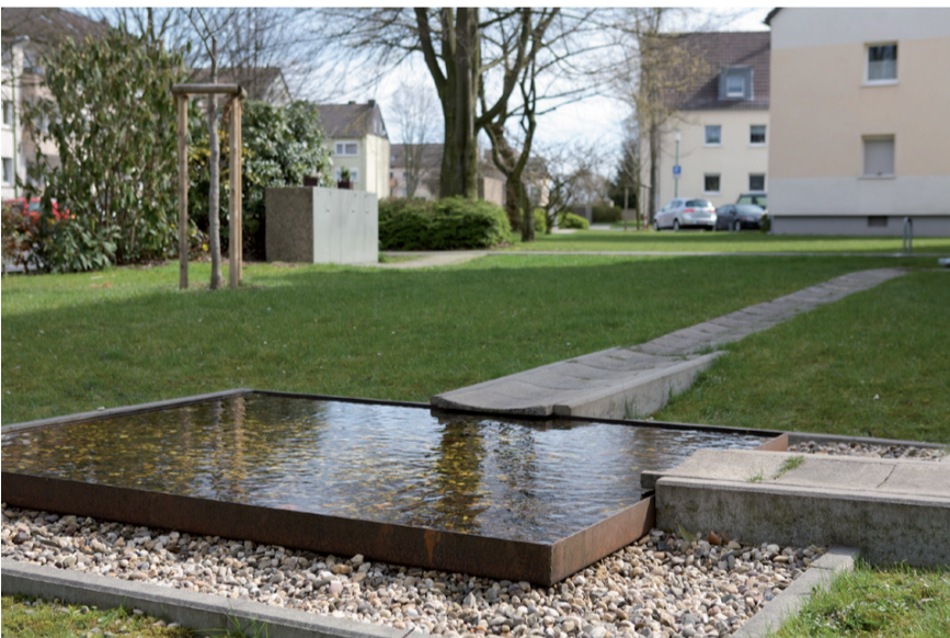
Abb.2: Rinnen und Versickerungsanlage, Allbau Siedlung in Essen
