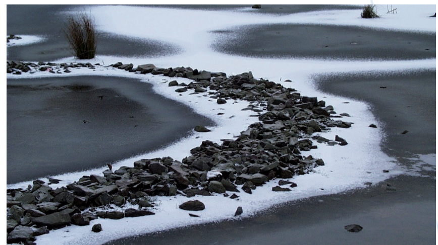
Abb. 1: Versickerungsanlage an der Universität Dortmund
