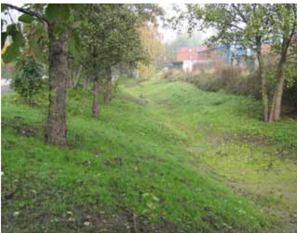
Berger Feld: neu erstellter Ableitungsgraben
