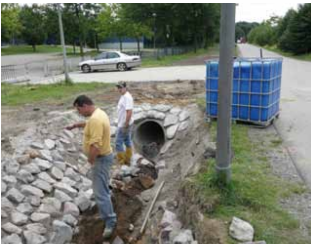
Berger Feld: Bau einer Wegequerung
