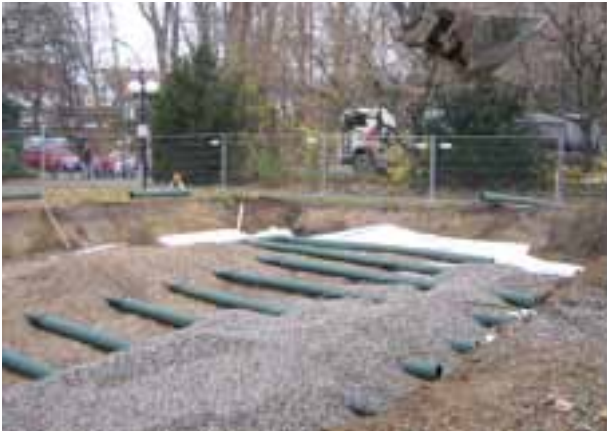
Abb. 7: Mulden-Rigolen-System im Bau
