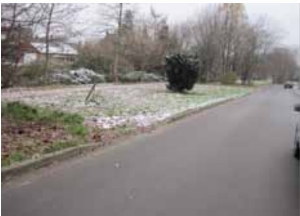
Abb. 5: Abgesenkter Bordstein und Mulde
