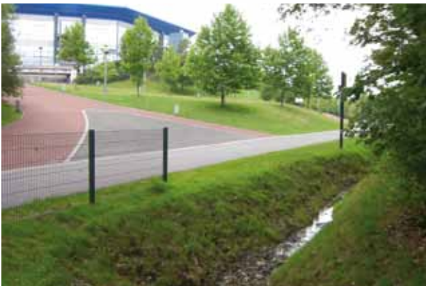
Abb.5: Offene Regenwasserableitung an der Veltins Arena auf Schalke
