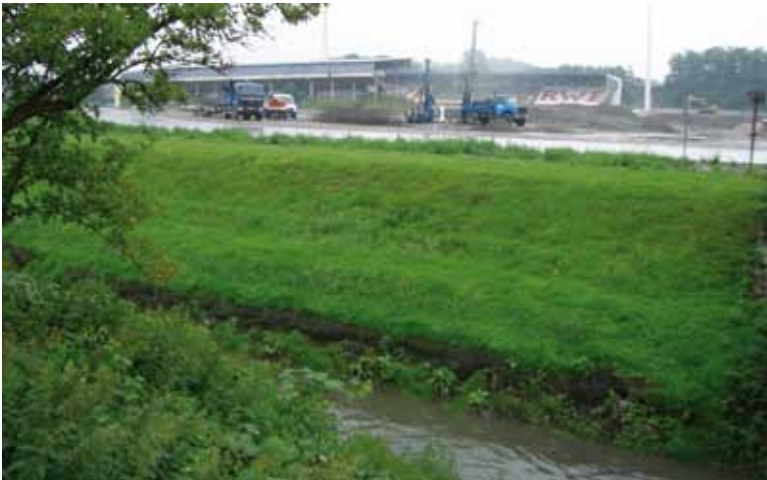
Abb.3: Baustelle am Georg Melches Stadion in Essen. Im Vordergrund die Berne
