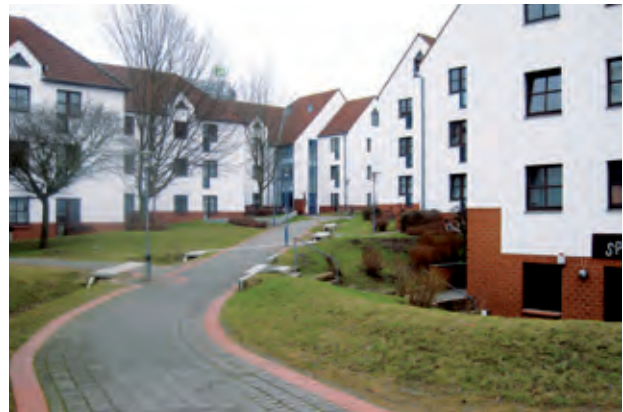
Bild 4: Ableitungsrinnen und nachprofilierte Außenanlagen
