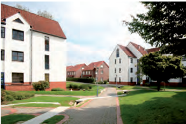
Bild 3: Ableitungsrinnen und nachprofilierte Außenanlagen
