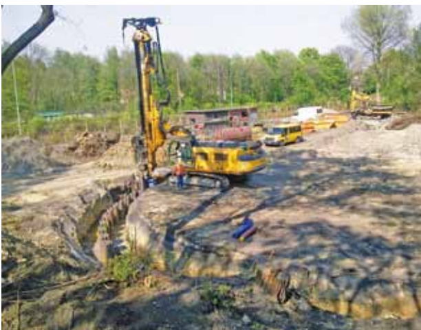
Abb 1: Die Spundwände für das Rückhaltebecken werden gesetzt...
