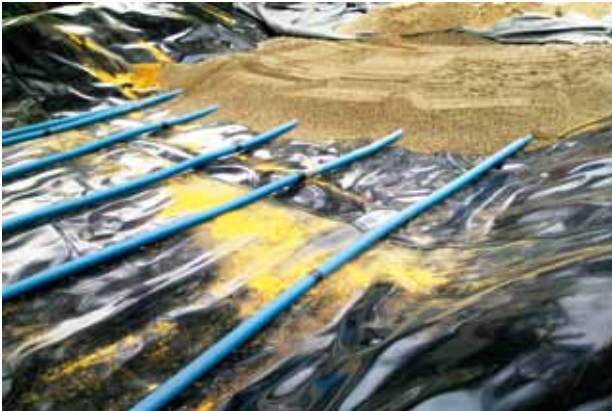
Abb 3: Aufbau des Retentionsbodenfilters
