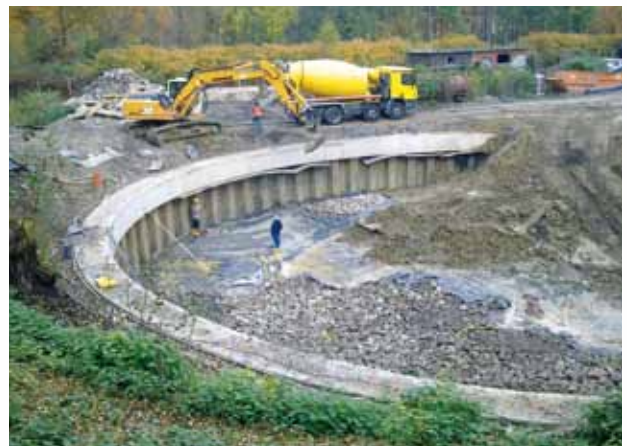
Abb 2: ... anschließend wird das Becken ausgehoben.
