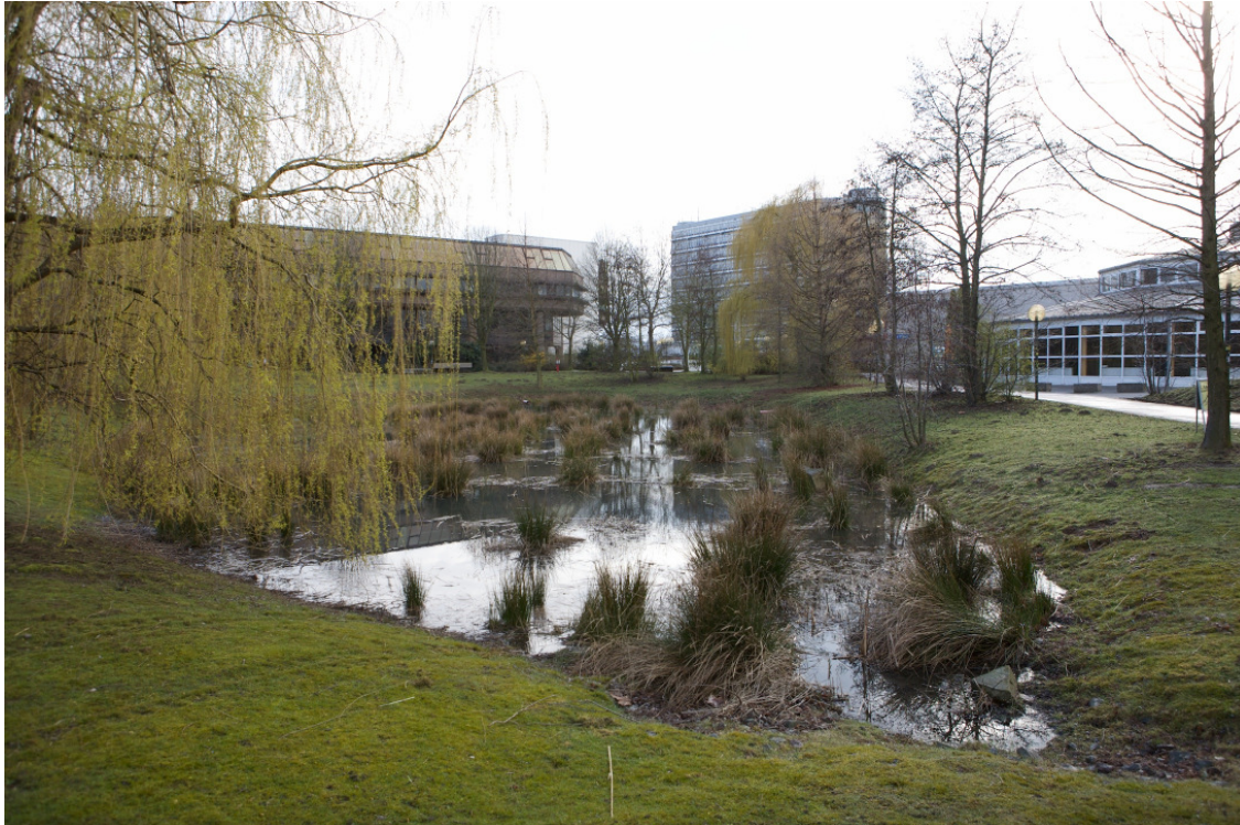
Abb. 6: Beispiel für eine Versickerungsanlage im halböffentlichen Raum, die auch als temporäre Überflutungsfläche genutzt werden könnte (Dortmund, Universität)
