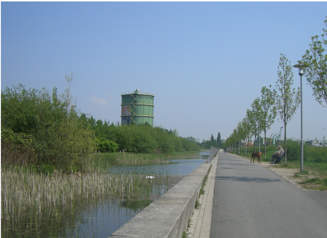
Bild 2: Die offene Regenwasserableitung schließt in einem Herner Gewerbegebiet die Lücke zum Gewässer
