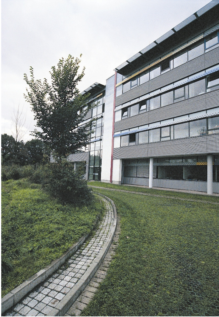
Bild 6: Die Niederschlagsabflüsse des Berufskollegs in Gelsenkirchen werden über Kaskaden auf die Grünflächen geleitet
