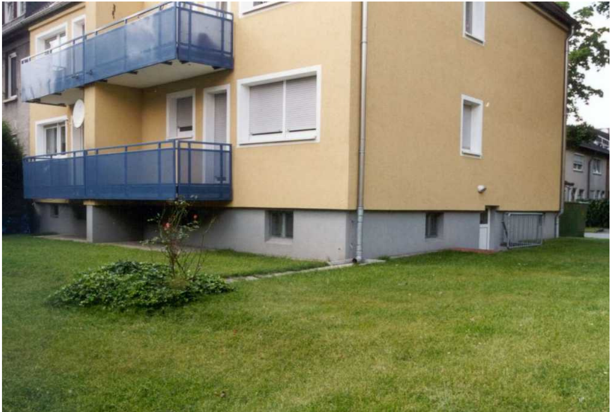
Bild 1: Umgesetzte Maßnahme an Liegenschaft des Wohnungsbaus
