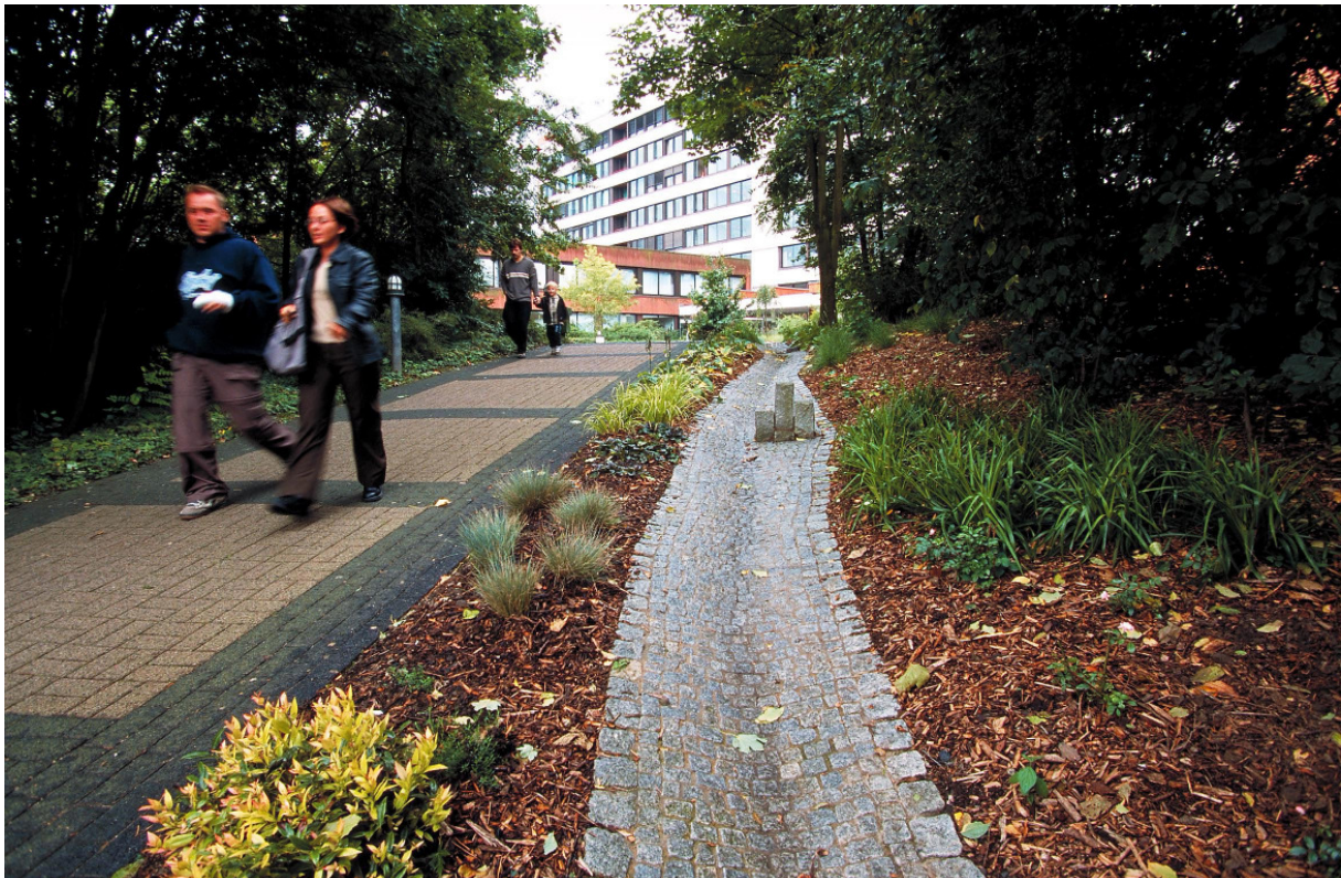
Bild 3: Offene Wasserführung am Elisabeth-Hospital, Teil des Hertener Projektstandortes
