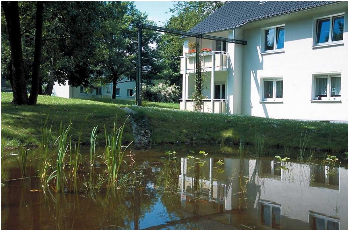
Bild 5: Die Zuleitung über berankte Rohrbrücken und die Anlage eines Feuchtbiotops werten das Wohnumfeld des Bochumer Projekts „Im Großen Busch“ deutlich auf
