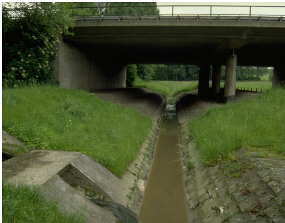
Abb. 2: typischer Schmutzwasserlauf des Emschersystems und Gewässer nach dem Umbau (Deininghauser Bach, Castrop-Rauxel)
