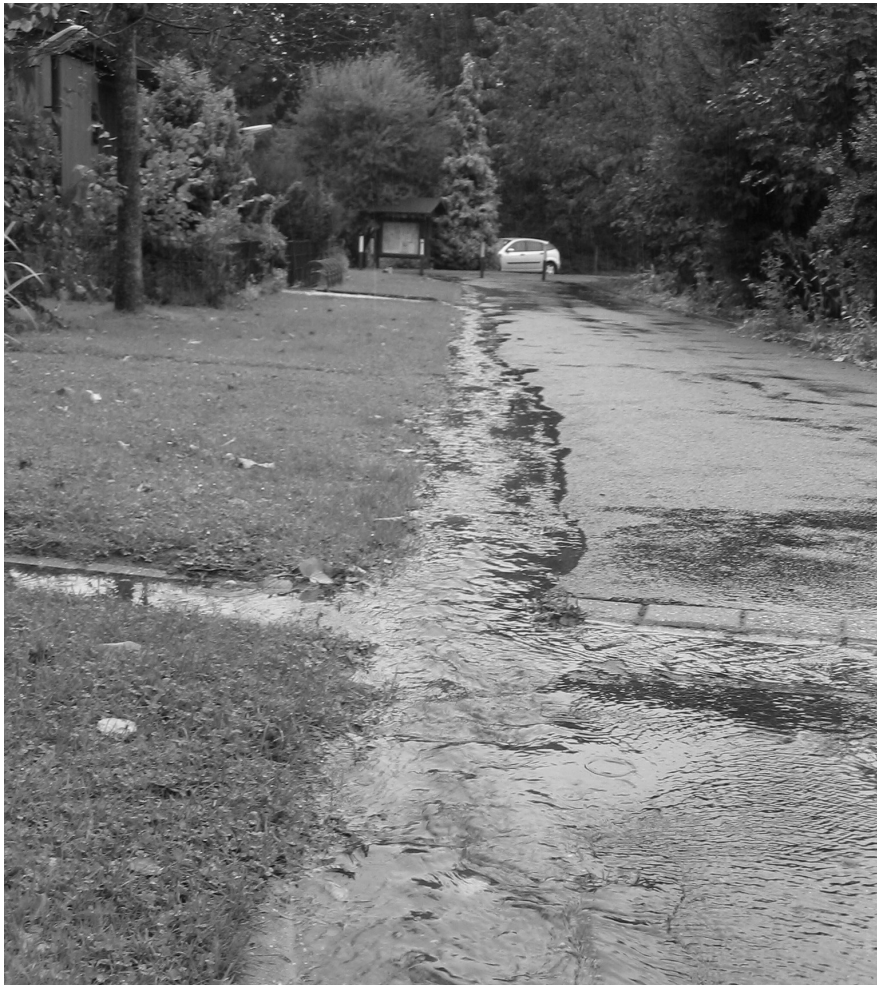
Abb 5: Heutige Entwässerungseingänge bei Regenfällen
