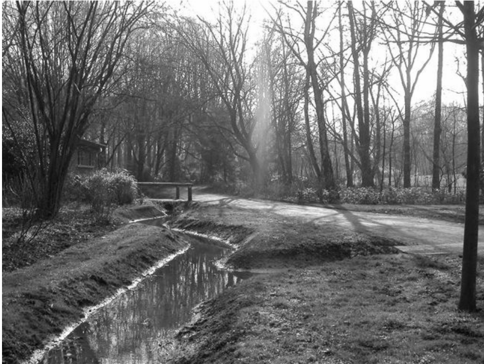
Abb. 3: das neue Entwässerungssystem im Bottroper Stadtgarten
