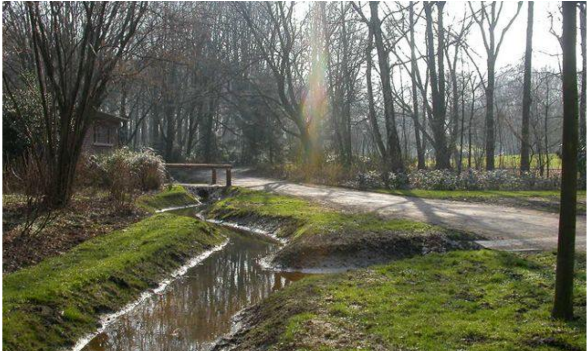
Bild 7: Grabensystem zur Niederschlagsableitung im Stadtgarten Bottrop
