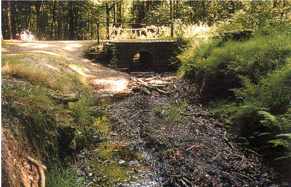
Abb. 2: Nebenlauf der Emscher bei Niedrigwasser – kaum wahrnehmbar
