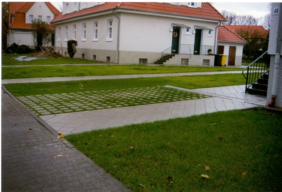
Abb. 4: Bottrop, Gartenstadt Welheim, saniertes Gebäude mit Muldenversickerung und wasserdurchlässiger Wegebefestigung
