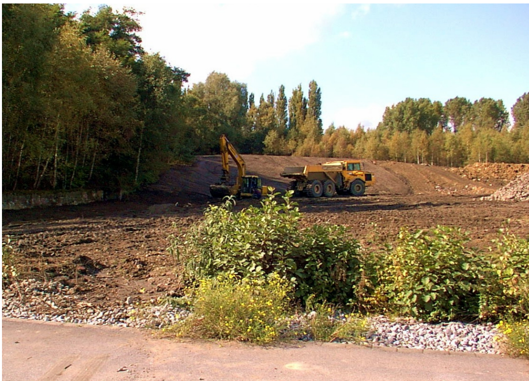
Abb.3: Fa. Albrecht, Muldenversickerung für 3 ha befestigter Fläche erfordert umfangreiche Bodenbewegungen
