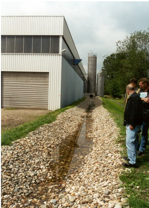
Abb.5: Fa. Thimm, offene Kiesrinne zur Ableitung des Niederschlagswassers zur Mulde
