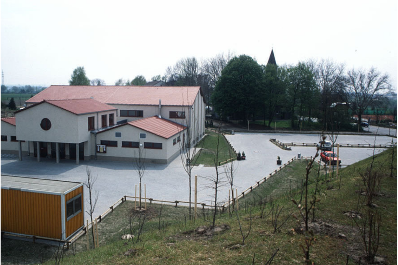
Abb. 10: Offene Ableitung des Regenwassers bei Gegengefälle über Pergolen-Übertragung der Rohrbrückentechnik aus dem Gewerbe auf den Wohnbereich
