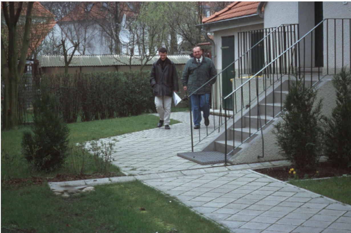
Abb. 12: Querung offener Rinnenführung mit Hauszuwegung
