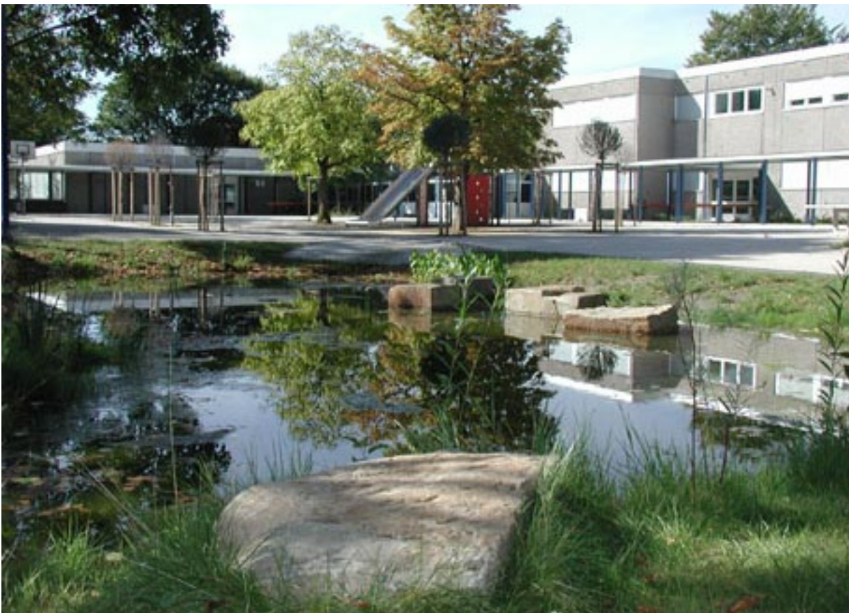
Abb. 17: Im Rahmen der Regenwasserbewirtschaftungsmaßnahmen neugestalteter Schulhof
