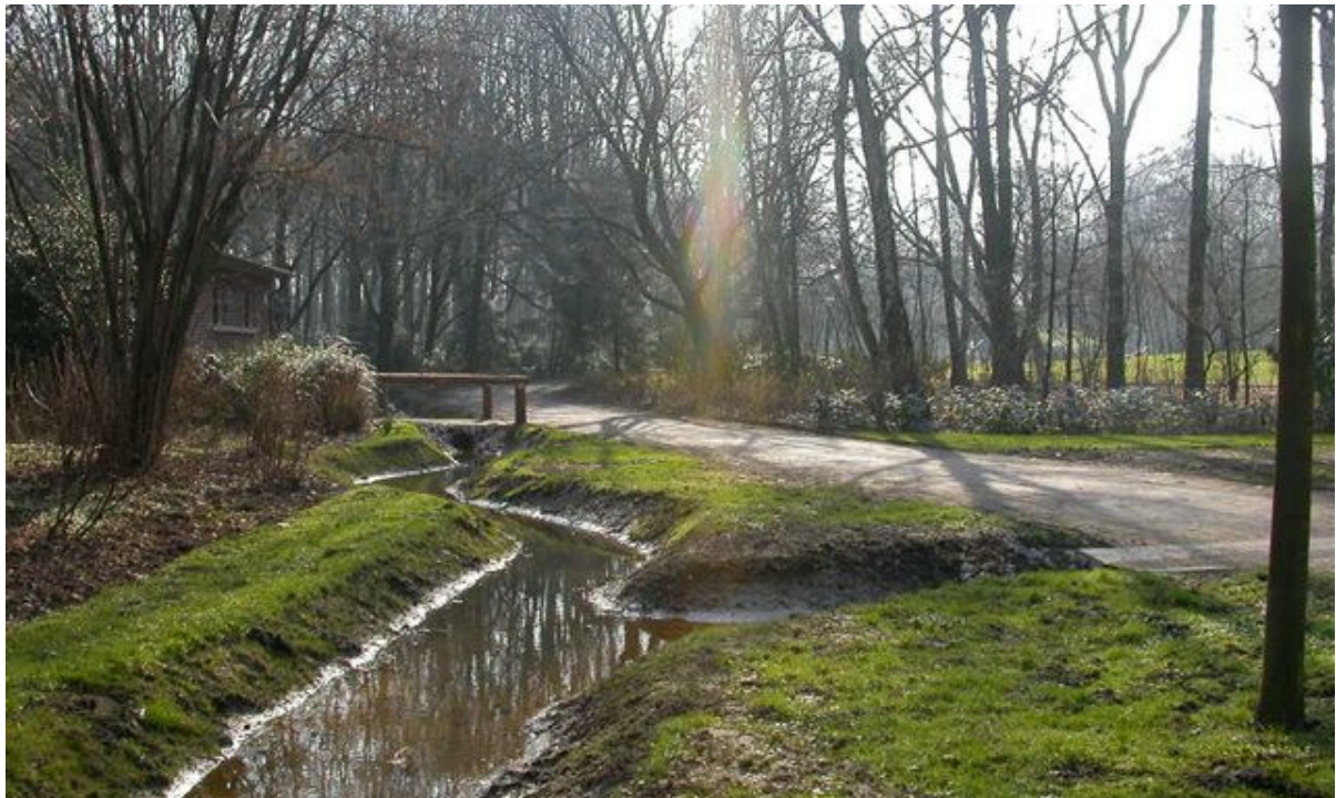
Abb. 5: Grabensystem zur Niederschlagsableitung im Stadtgarten Bottrop
